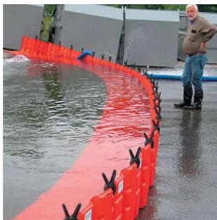
●ボックスウォールは地面に置くだけで洪水から守る土のうに代わる次世代緊急洪水防護システムです。特殊な工具を必要とせず、かかる水圧を利用して固定するのでアンカーボルト等の固定も不要です。1個3.4kgと軽量で設置移動も容易で、重ねて収納もできるので場所をとりません。
