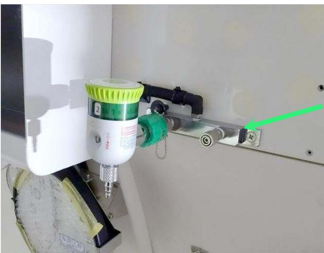
流量計を外せば、川重型ピン式酸素接続口ですので、病院のレスピレーターも接続可能です。
