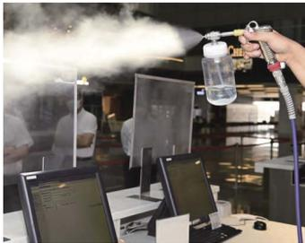
抗ウイルス加工とは一回の施工で、長期に渡ってウイルスを増殖させない状態にすること。光を全く必要とせず、暗所においても効果を発揮する『無光触媒剤』を、特殊なスプレーガンで噴霧し、短時間（10分～30分）であらゆるものに、安全に加工します。
