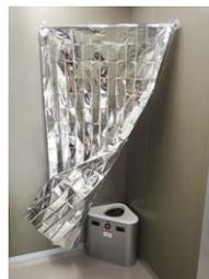
● 普段は椅子として使用し、災害や停電、故障によってエレベーター内に閉じ込められた時に、収納されている非常用品を使って、復旧や救助まで安全に待機することができます。
